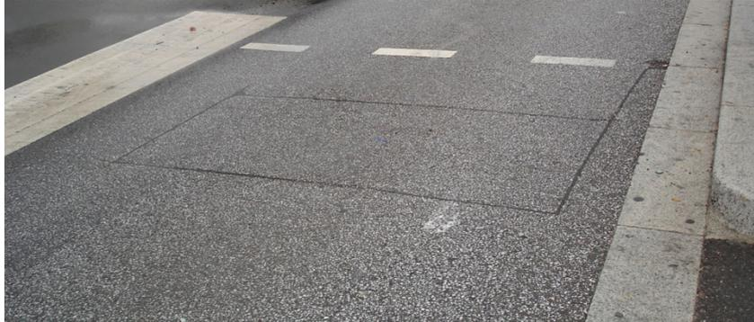
**Figure 1-10** : photographie d'une boucle électromagnétique simple. On distingue le trait de scie rectangulaire (la boucle elle-même) et le trait de scie rectiligne qui relie la boucle au générateur électrique et au détecteur de champ magnétique.
