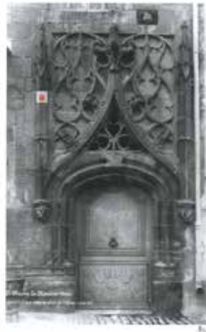
813. FRONTON CINTRÉ BRISÉ À VOLUTES SUPÉRIEURES RENTRANTES A Adoucissement figuré (voir p. 402). B Masque (voir p. 417). C Agrafe (voir p. 416). Hôtel Flaubert, Paris.
